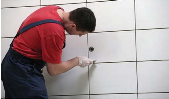
Laattojen reunojen puhdistus ennen saumausta.
