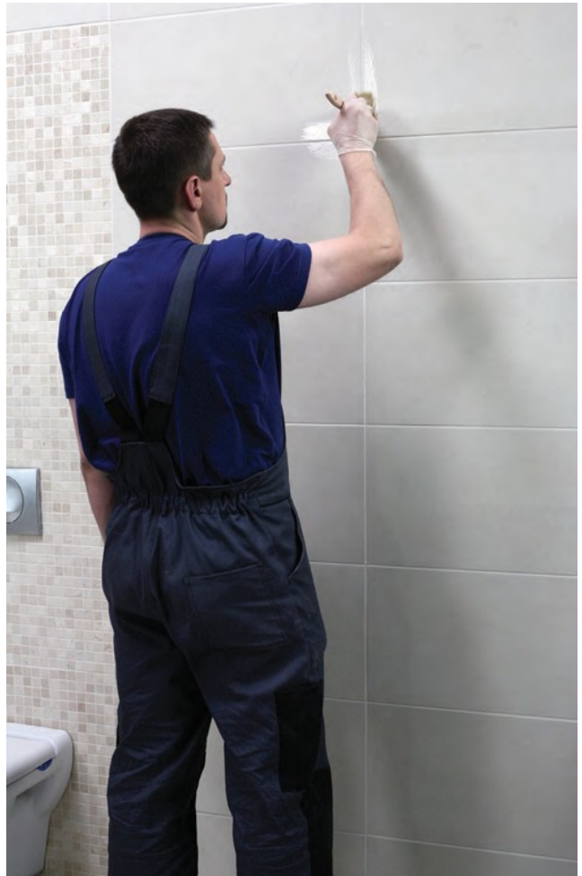
Saumasainetta voidaan suojata lisäksi silikonikyllästeellä Ceresit CT 10.
