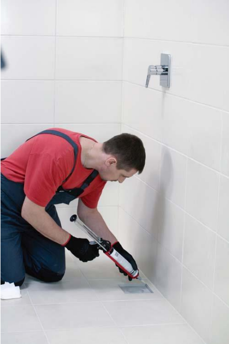
Valuma-aukon reunan tiivistäminen
