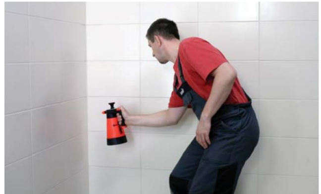
Vastatäytetyn sauman kostuttaminen saippuavedellä
