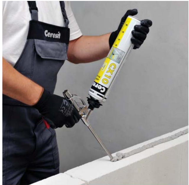
Vaahdon levittäminen kevytbetoni harkkoja liitettäessä.
