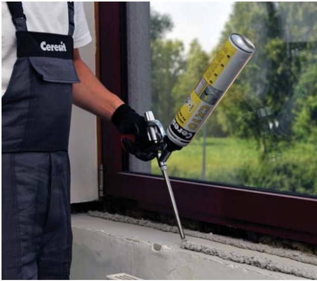
Vaahdon levittäminen ikkunalaudan asentamisessa
