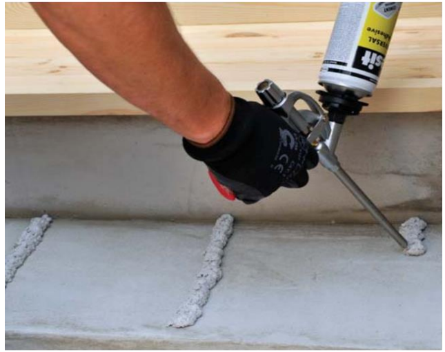
Vaahdon levittäminen portaiden asentamisessa
